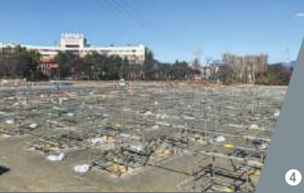
2 組立用足場設置
