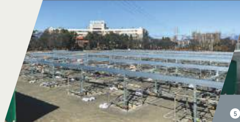
3 カーポート躯体組立
